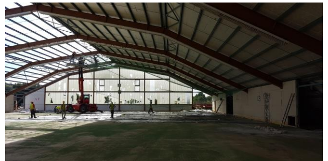
Abb. 3: Demontage asbesthaltiges Wellasbestzementdach
