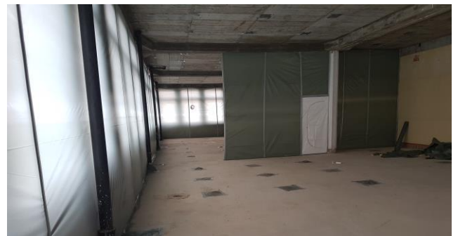
Abb. 3: Aufbau Abschottung für ASI-Arbeiten
