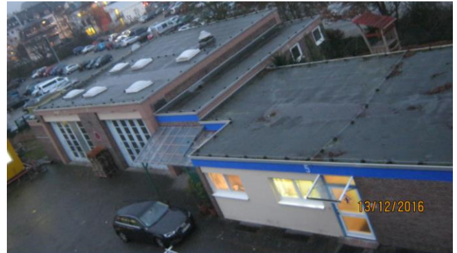
Abb. 2: Ansicht Werkstatthalle + Nebengebäude
