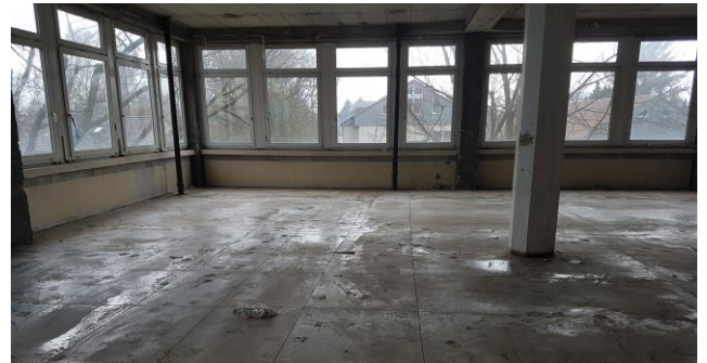
Abb. 2: Nasstrennschnitte Estrich
