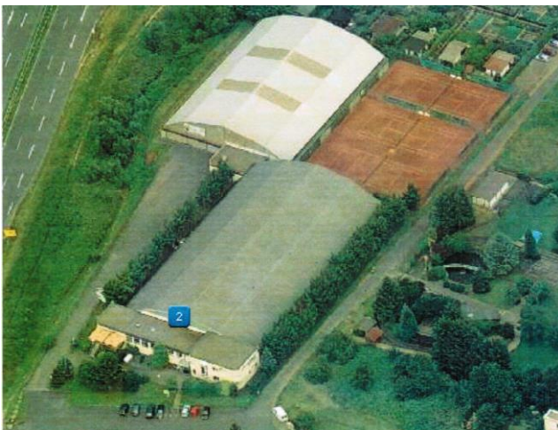
Abb. 1: Luftbild abzubrechender Gebäudekomplex
