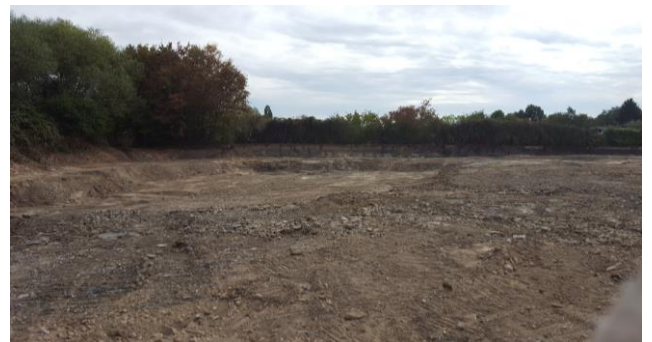
Abb. 4: sanierter Bereich schadstoffbelasteter Böden (hintere Halle)
