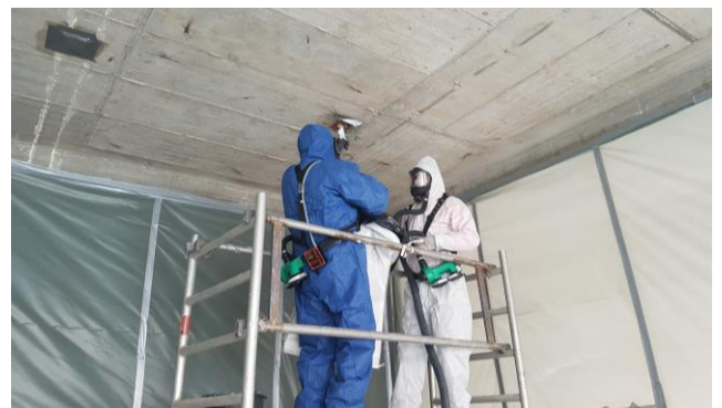
Abb. 4: Ausführung ASI-Arbeiten
