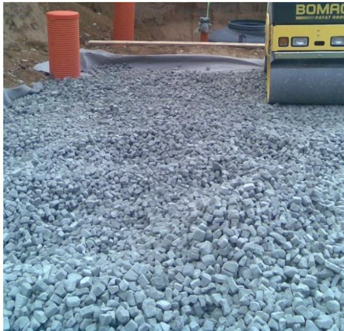
**Bild 10** Schaumglasschotter in der Baugrube mit Kontrollschächten der zusätzlich nötigen Drainage
