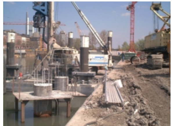
Bild 3: Pfahlherstellung vom Ponton
