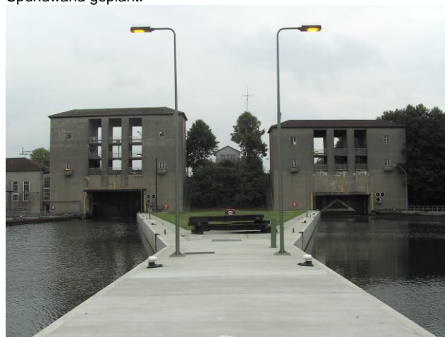
Abb. 1: Ansicht Unterhaupt (rechts: umzubauende Westkammer)
